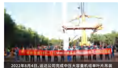
2022年8月4日,运达公司完成中压大容量机组单叶片吊装
